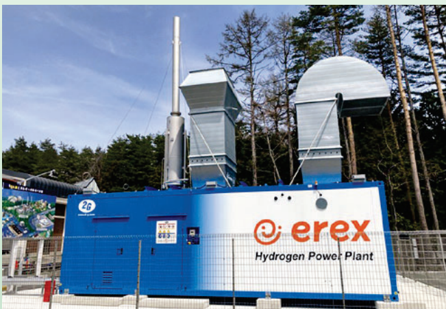
Cogenerazione a idrogeno
