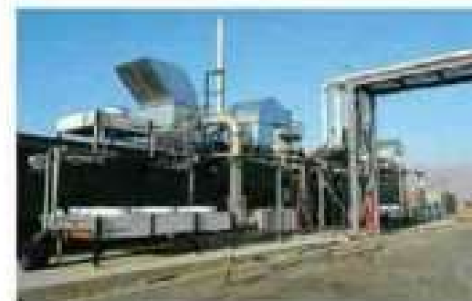
IMPIANTO DI TRATTAMENTO RIFIUTI ORGANICI (ZERO WASTE ENERGY, SAN JOSE, CA)
