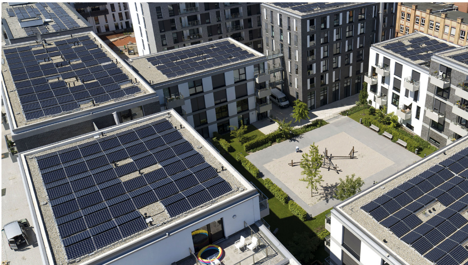
SOPRA I tetti fotovoltaici sugli edifici e l'elettricità da fonti rinnovabili alimentano l'elettrolizzatore situato nella Centrale Energetica del quartiere (Maximilian Kamps, Agentur Blumberg GmbH)
