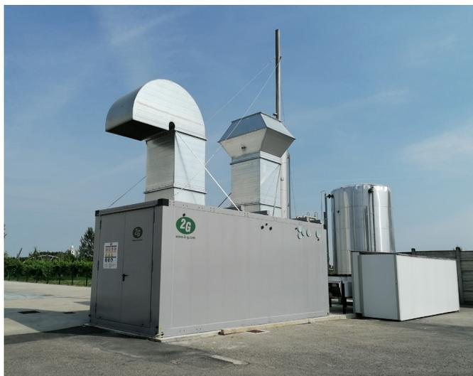
alimentato a gas naturale, che fornisce energia elettrica e termica in modo sostenibile e ottimizzato.
