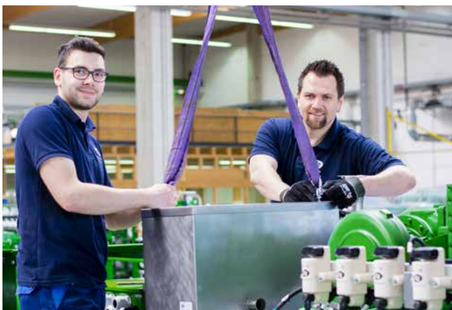
Techniker bei der Installation einer Anlage für Kraft-Wärme-Kopplung, die mit Gas betrieben wird und sowohl Strom als auch Wärme produziert.
