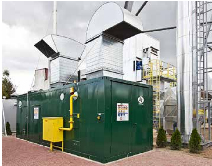
Containerisierte, motorische KWK-Anlagen lassen sich ohne lange Planungsverfahren realisieren.
