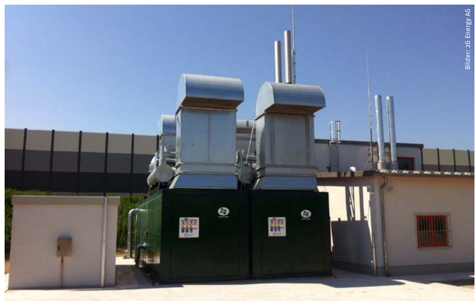
Bild 1: Containerlösung mit integrierten BHKW im Stahlcontainer (links) und in Betoneinhausung (rechts) sowie eine reale Installation im Stahlcontainer (unten).
