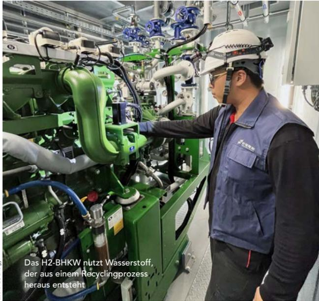
Das H<sub>2</sub>-BHKW nutzt Wasserstoff, der aus einem Recyclingprozess heraus entsteht
