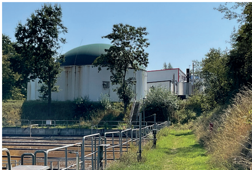
Bild 2. Biogasanlage mit Fermenter
