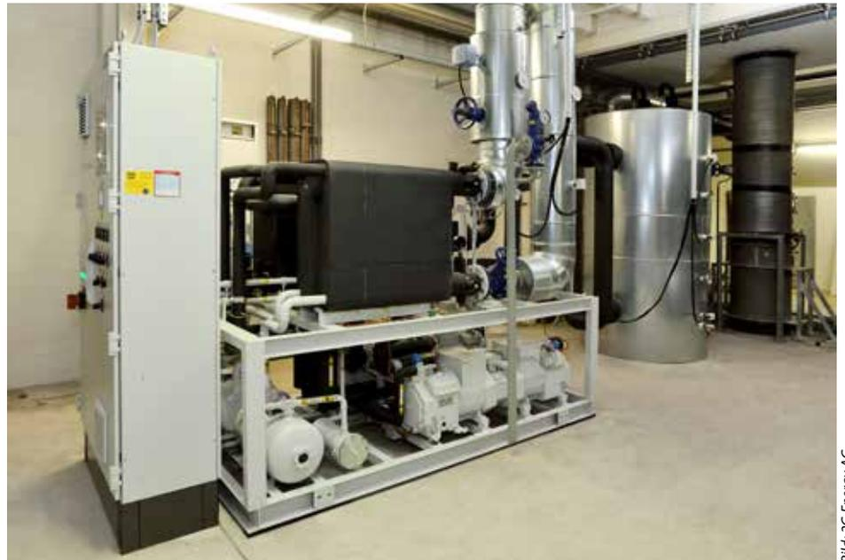
Luft-Wasser-Wärmepumpe in Bad Lauterberg mit 200 kW thermischer Leistung
