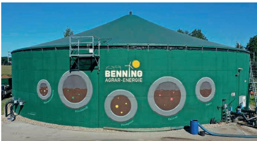
Bild 3. In diesem Winterlager wird wertvolles flüssiges Gärprodukt als Nährstofflieferant und Humusbringer bis zum Frühjahr aufbewahrt
