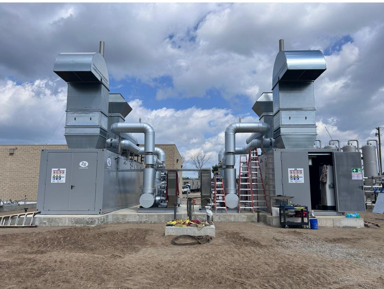
Die Clinton River Water Resource Recovery Facility in Michigan, USA, ist eine kommunale Einrichtung, die sich auf die Aufbereitung von Abwasser konzentriert. Mit dem Ziel, Betriebskosten zu senken und zugleich nachhaltige Energiequellen effizient zu nutzen, entschied sich die Kläranlage für eine moderne KWK-Lösung von 2G Energy. Die Erzeugung von Strom und Wärme aus vorhandenem Klärgas trägt maßgeblich zur Optimierung der Energieversorgung vor Ort bei.
