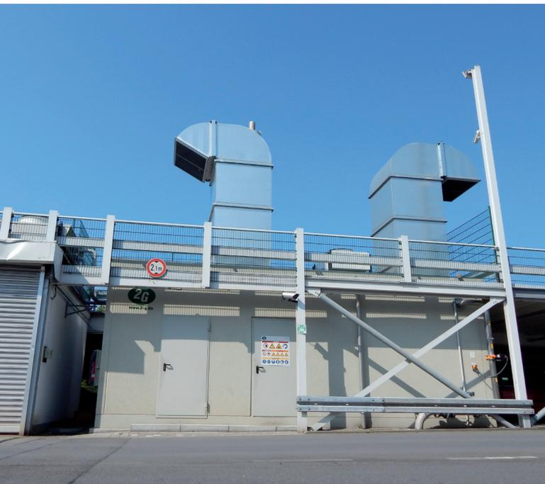
(A) in 10 m Entfernung) erfüllt wurden, gab es für die Optik eine ebenso geniale wie einfache Lösung: die Betonschallhaube wurde samt agenitor in das Parkhaus des Krankenhauses eingelassen. Hierzu wurde in dem Oberdeck eine Aussparung geschaffen, durch die sämtliche Komponenten mit Hilfe eines Krans eingebracht wurden. Farblich wurde die Betonschallhaube an die Farbe des Parkhauses angepasst.
