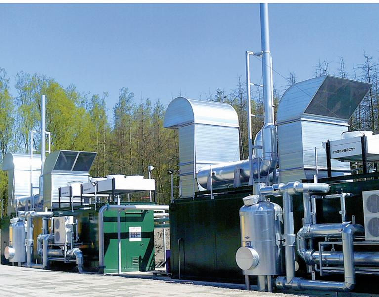
gewonnene Klärgas wird seit April 2017 von zwei avus 500plus als Brennstoff zur Erzeugung elektrischer und thermischer Energie genutzt. Die zwei Aggregate aus dem Hause 2G produzieren jeweils 550 kW elektrische und 543 kW
