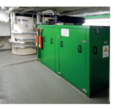
Die g-box 50 wurde platzsparend in einem eigens dafür errichteten Tiefbunker neben der Orangerie des Schlosshotels untergebracht und ist durch einen Versorgungsgang erreichbar. Für die nach zehn Jahren anstehende Revision muss nur die Deckplatte des Bunkers entfernt und das Modul per Kran herausgehoben werden. Um das Schloss mit der g-box 50 zu verbinden, wurde in drei Metern Tiefe eine 170 Meter lange Rohrleitung durch den Schlosspark und unter dem Wassergraben grabenlos verlegt.
