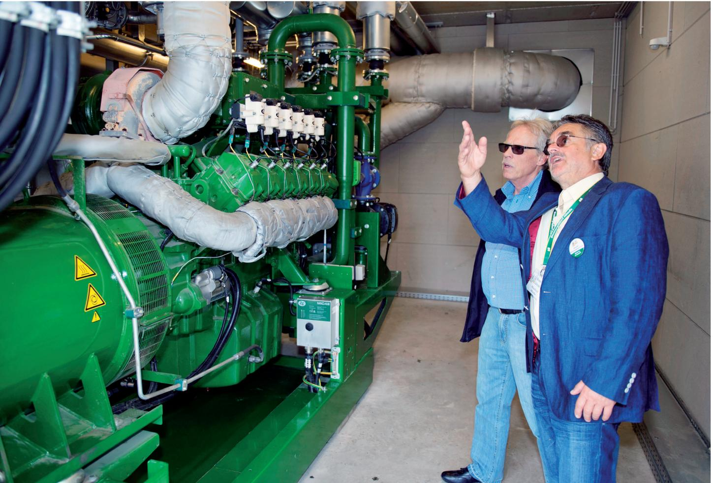
*Jühnde ist das erste Bioenergiedorf seiner Art in Deutschland. Auf Basis von Biomasse erzeugt das Dorf u. a. mit Hilfe zweier avus 500plus (550 kW elektrisch und 526 kW thermisch) aus dem Hause 2G doppelt so viel Strom wie es selbst benötigt – zudem werden die anliegenden Häuser hocheffizient mit Wärme versorgt.*
